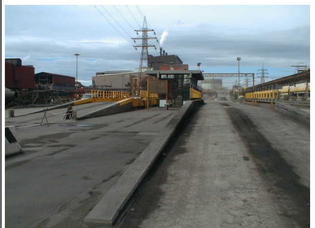
VISTA FRONTALE DELLE DUE BILANCE CON LE RELATIVE RAMPE DI ACCESSO
