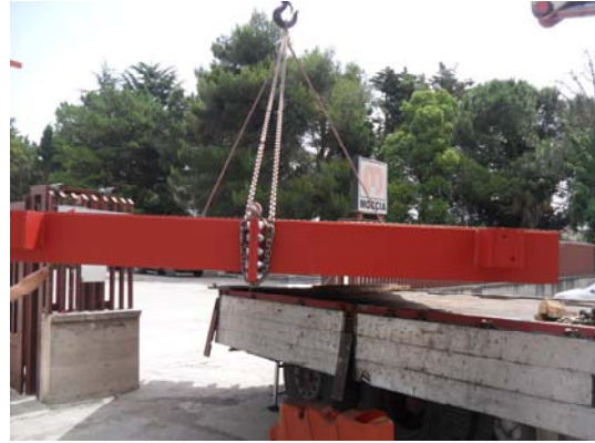
FASE DI SCARICO DEI SEMIPANNELLI
