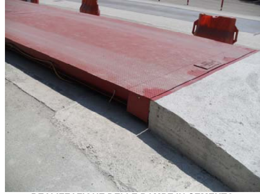
REALIZZAZIONE DELLE RAMPE IN CEMENTO
