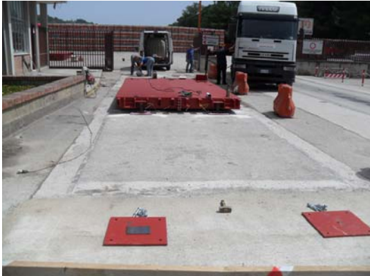
SISTEMAZIONE DELLE PIASTRE DI APPOGGIO
