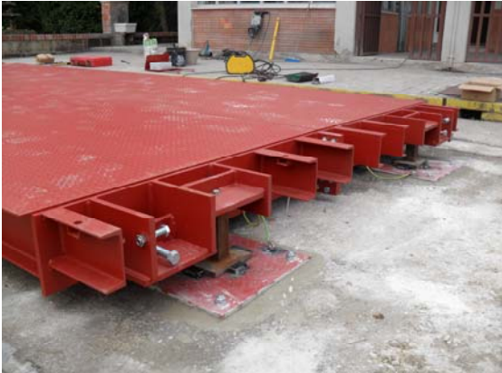
MONTAGGIO DEI PANNELLI SULLE FINTE CELLE
