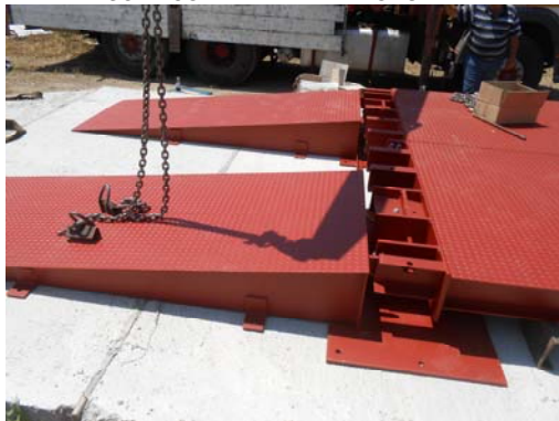
MONTAGGIO DELLE RAMPE
