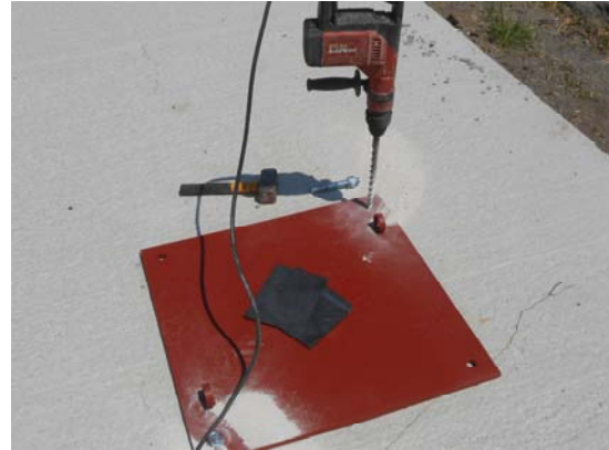
FISSAGGIO DELLE PIASTRE DI APPOGGIO
