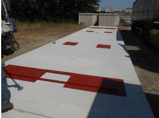
SISTEMAZIONE DELLE PIASTRE DI APPOGGIO
