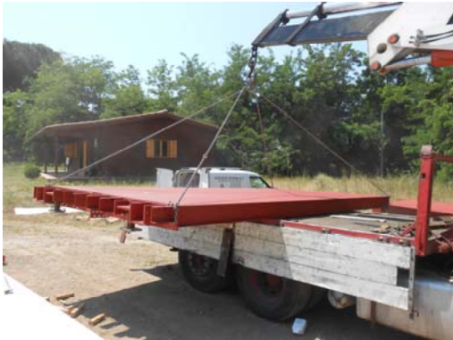
SCARICO DEI PANNELLI MODULARI
