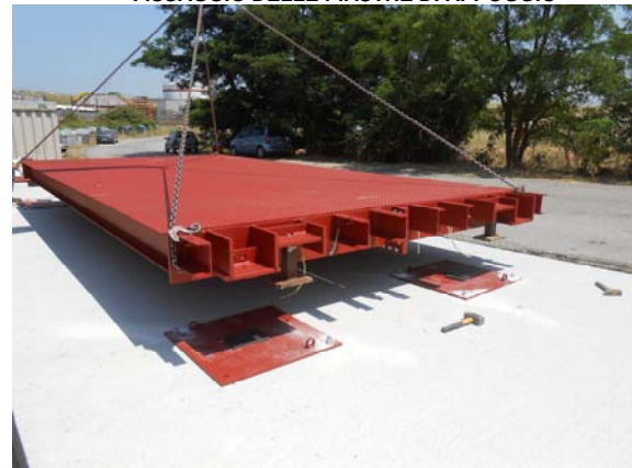
MONTAGGIO DEI PANNELLI MODULARI
