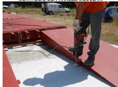
FISSAGGIO DELLE RAMPE
