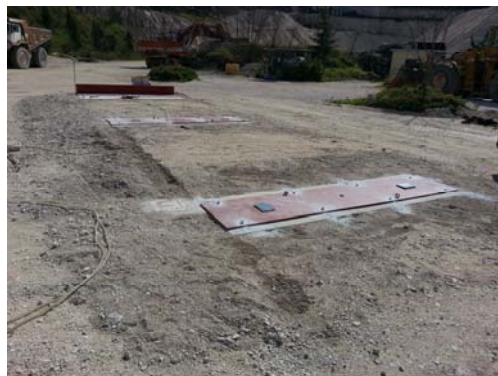
Montaggio delle piastre sulle basi in cemento
